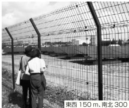
東西150m、南北300mの敷地(3.8%)に太陽光パネル13,632枚。出力2MW
